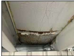
漏水石膏板損壞
