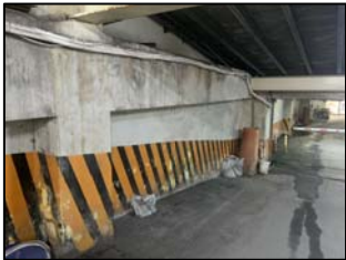
車道牆面漏水
