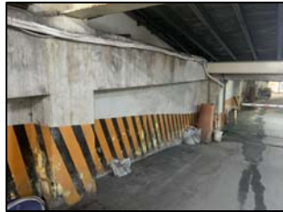
車道牆面漏水
