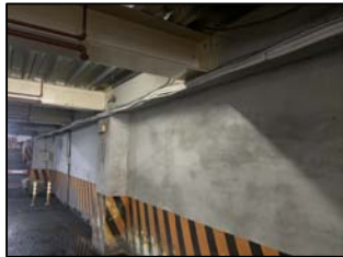
車道牆面漏水
