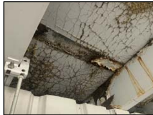
漏水石膏板損壞
